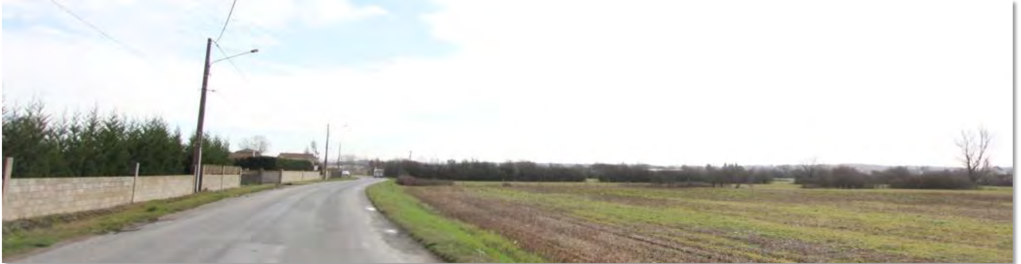
Entrée de ville N°5 : cette entrée de ville n'est pas du tout aménagée en conséquence pour le moment mais le projet des Portes du Tarn qui va venir s'implanter à droite de la voie, va considérablement transformer cet espace. C'est une entrée à enjeux qui sera de plus en plus fréquentée
