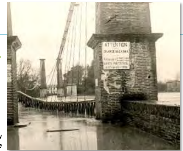
Le pont suspendu lors de la crue du 3 Mars 1930 – Source : la Dépêche
