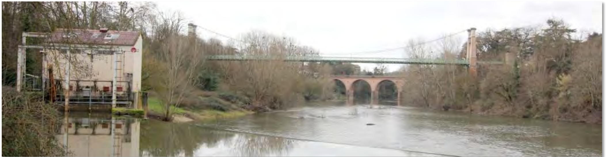
L'Agout depuis les berges sous le site du Castela, vue sur le pont suspendu en premier plan et le pont de la voie ferrée
