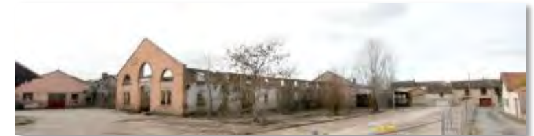
Anciens bâtiments de l'Arçonnerie, représentant un patrimoine industriel
