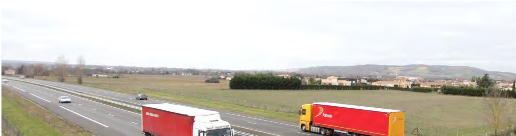
Certaines habitations se situent littéralement au bord de l'autoroute. Une bande agro-paysagère doit être aménagée spécialement pour intégrer ces développements depuis l'autoroute A68 et diminuer les nuisances
