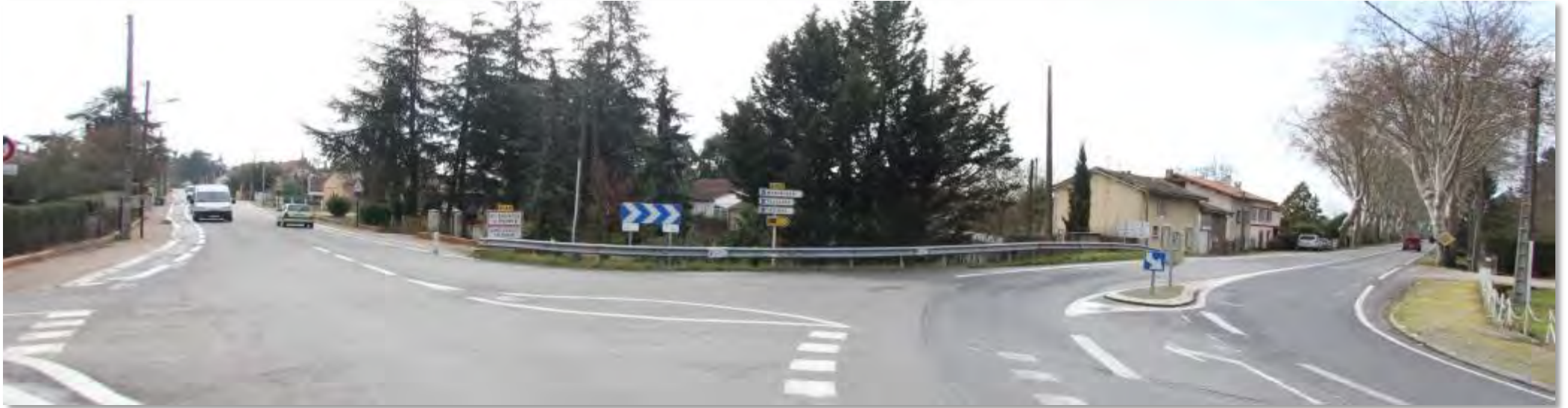
Entrée de ville N°7 : Elle définit bien l'arrivée dans le centre dense mais son aménagement est un carrefour strictement routier
